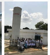
Réservoir d'Azote liquide 21 000 litres
